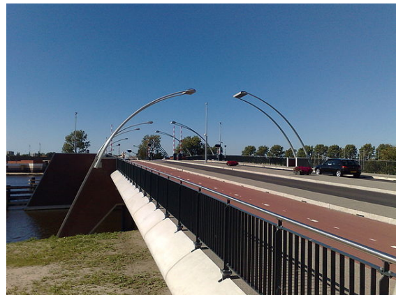
De nieuwe Schoterbrug in Haarlem Noord
