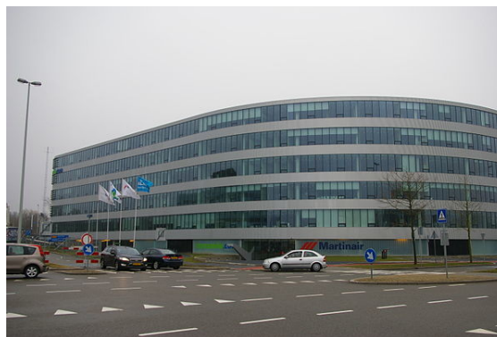
TransPort Building - Kantoren van Martinair en Transavia, Schiphol-Oost
