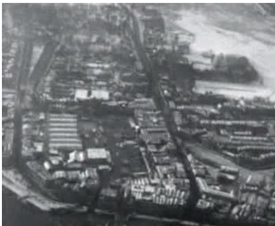
Luchtopname uit 1927 van de besneeuwde omgeving van Rotterdam, de buitenwijken en de havens. Te zien zijn de Leuehaven, Zalmhaven, Parkhaven, Sint Jobshaven, Schiehaven en de elektriciteitscentrale.
