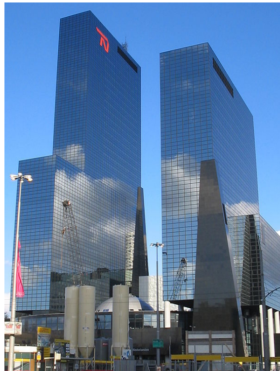
Gebouw Delftse Poort
