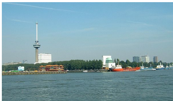
Euromast en ventilatiegebouw Maastunnel
