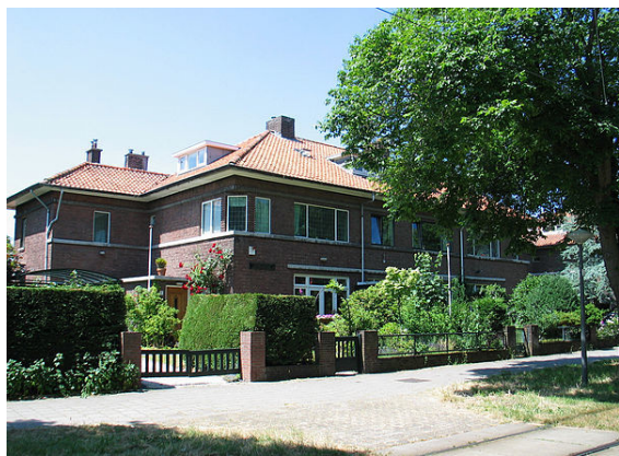
Woonhuis Wilhelmina aan de Nieuwe Parklaan in Den Haag
